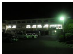
駐車場から見た教室
